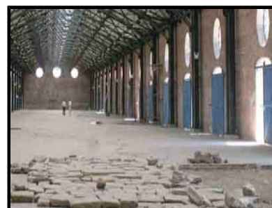
La remoción de parte del piso de La Aduana continuó en marzo, pese a que el año pasado la Ministra de Cultura dijo que esto no se haría de ninguna manera. (Foto Katya Alvarado)
